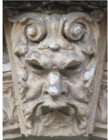
Рис. 9. Львів, маскарон на замковому камені головного входу в споруду по вул. П. Саксаганського, 13, арх. фірма М. Уляма, 1913–1921 рр. Фото Лідії Кукіль
