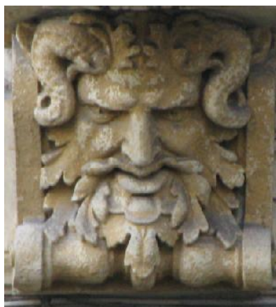
Рис. 5. Львів, маскарон на модільонах карниза першого поверху кам'яниці по вул. Каменярів, 7, арх. Ю.-К. Яновський, ск. Л. Марконі (?), 1877 р. Фото Лідії Кукіль
